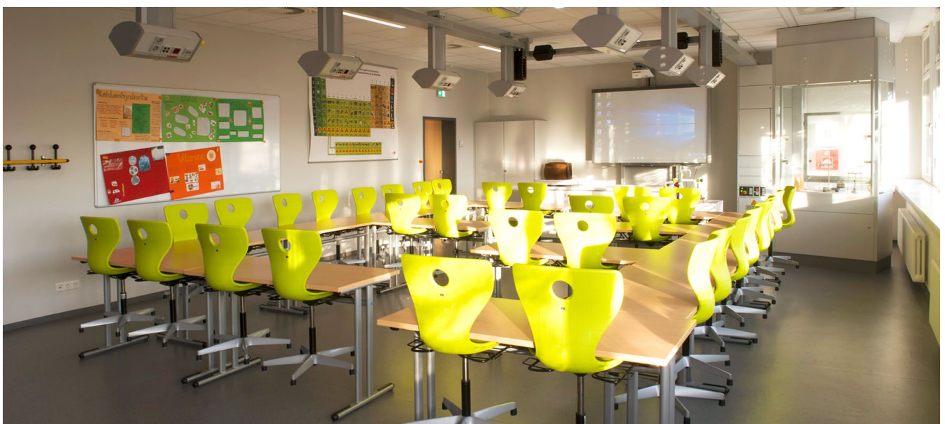
▲ Im Rahmen des Umbaus wurden auch neue Fachräume für Chemie errichtet, deren Digestorien ebenfalls an die Lüftungsanlage angeschlossen sind.
