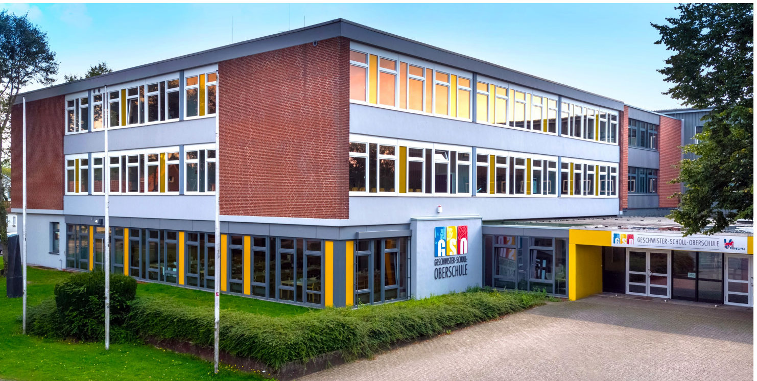
▲ In der Geschwister-Scholl-Oberschule in Vechta erfolgten die Umbaumaßnahmen im laufenden Schulbetrieb.
