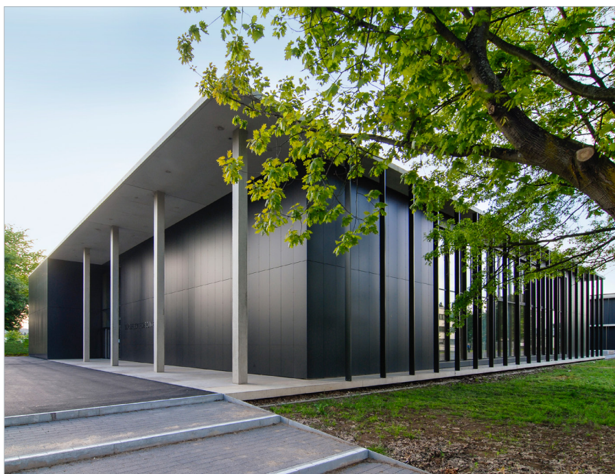
▲ En fonction de la situation, les stations météorologiques indiquent, grâce à leur interaction avec les capteurs intégrés aux bâtiments, s'il faut descendre les stores ou les remonter du fait d'un vent trop violent. Photo © Olaf Herzog
