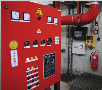
Foto: vlnr: Sprinklerhauptzentrale mit BMZ, VIEW-Melder im Zwischenboden der Schaltanlage, linienförmige Rauchmelder BEAM im Trockenkammerblock, (MB)
