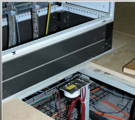
Foto: vlnr: Sprinklerhauptzentrale mit BMZ, VIEW-Melder im Zwischenboden der Schaltanlage, linienförmige Rauchmelder BEAM im Trockenkammerblock, (MB)
